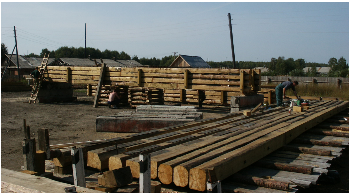
Рисунок 2 – Изготовление составных прогонов из бревен длиной 15 м Источник: составлено авторами.
