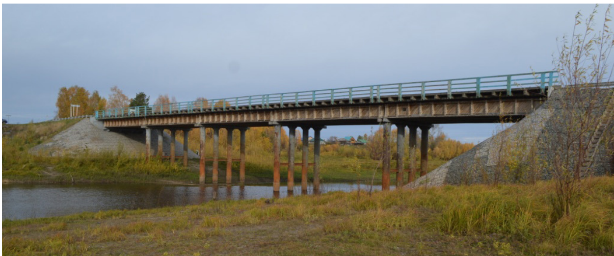
Рисунок 8 – Общий вид моста через р. Тевриз на участке 76+150 км Источник: составлено авторами.
