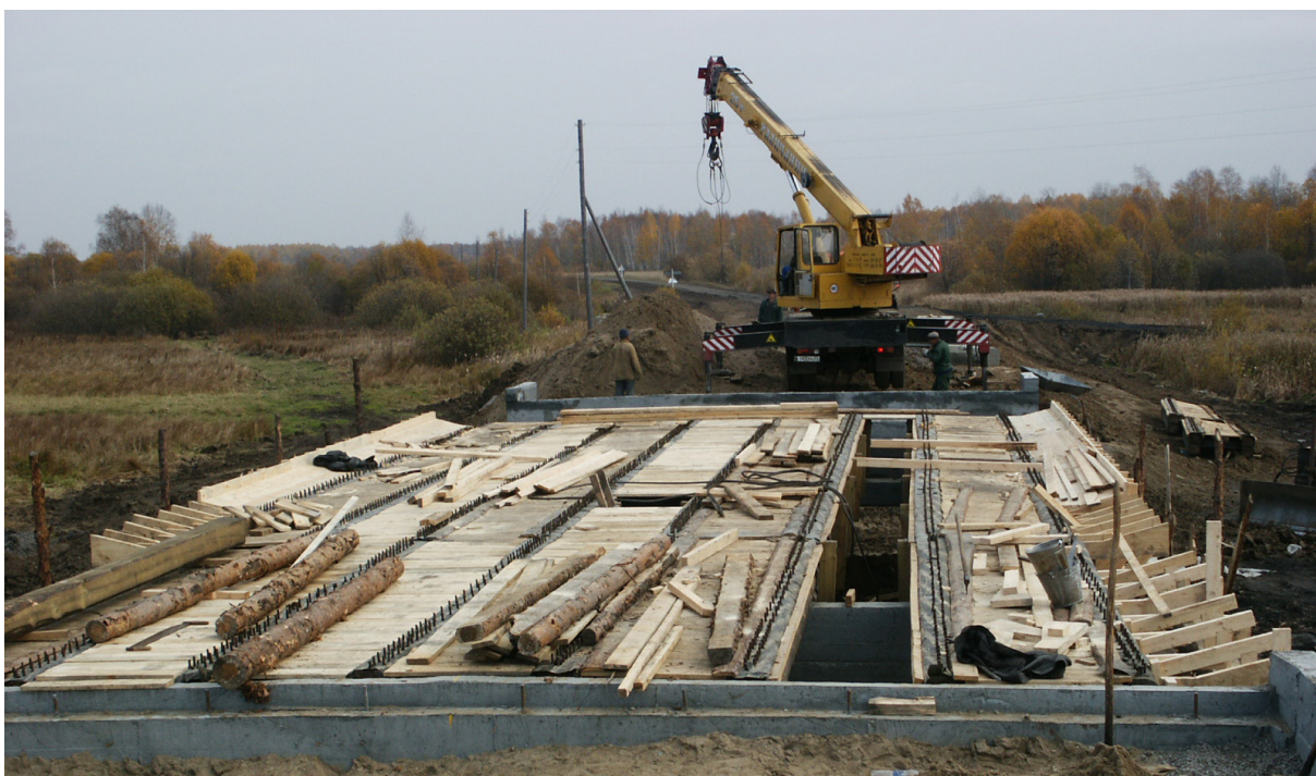
Рисунок 3 – Изготовление железобетонной плиты проезжей части (опалубочные работы и устройство нагельных соединений) Источник: составлено авторами.
