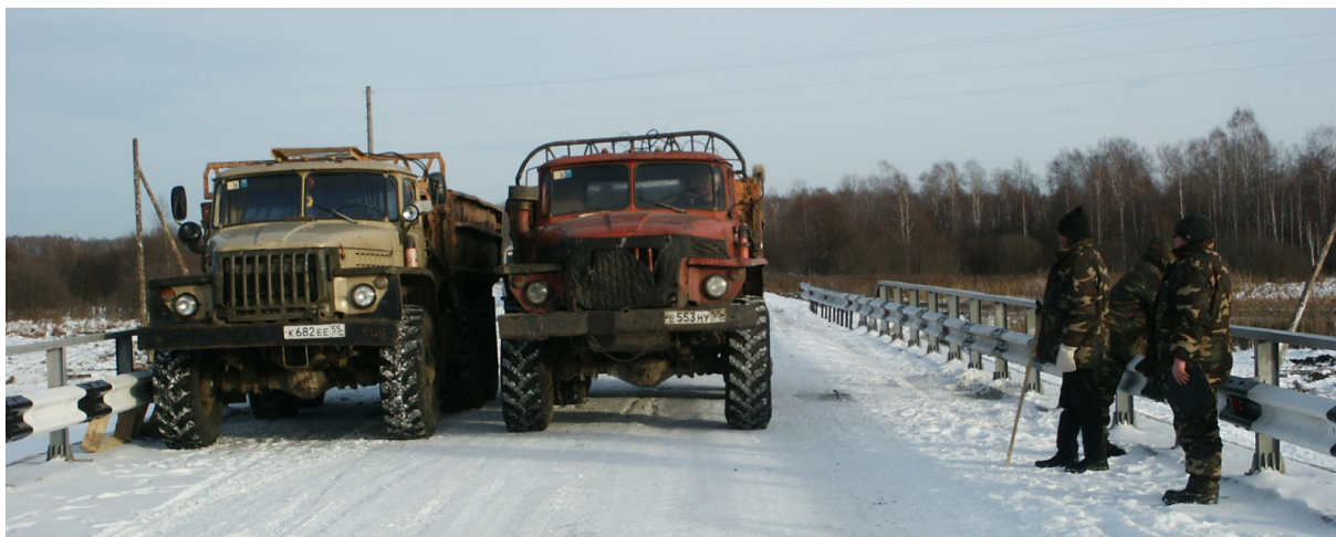
Рисунок 4 – Испытание моста через р. Нягов. Установка временной нагрузки Источник: составлено авторами.
