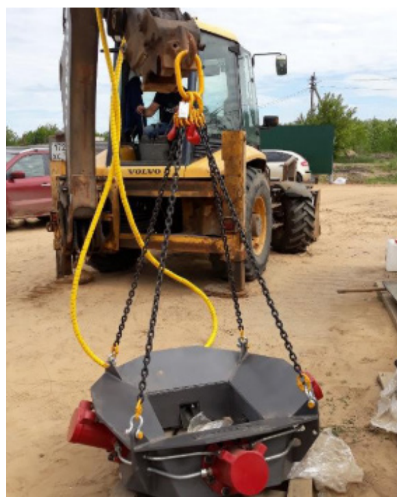
Рисунок 1 – Оборудование для срезки оголовков железобетонной сваи, установленное на экскаваторе Volvo BL-71.
