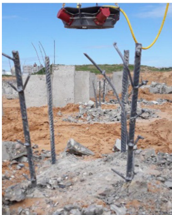
Рисунок 6 – Полное срезание оголовка железобетонной сваи до уровня основания Источник: составлено авторами.
