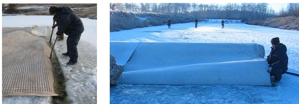
*Рисунок 4 – Погружение геокомпозита в «майну» и протаскивание его подо льдом
