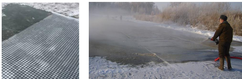
*Рисунок 3 – Укладка геокомпозита (геосетка + геотекстиль)
