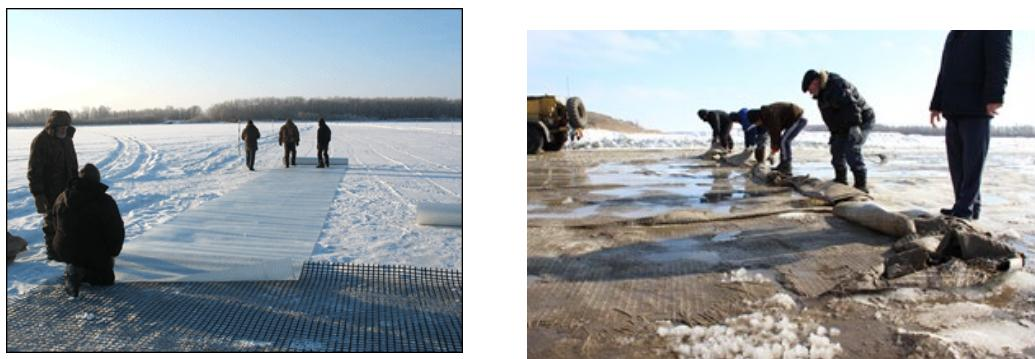
*Рисунок 6 – Укладка геосинтетики зимой и извлечение её весной*
