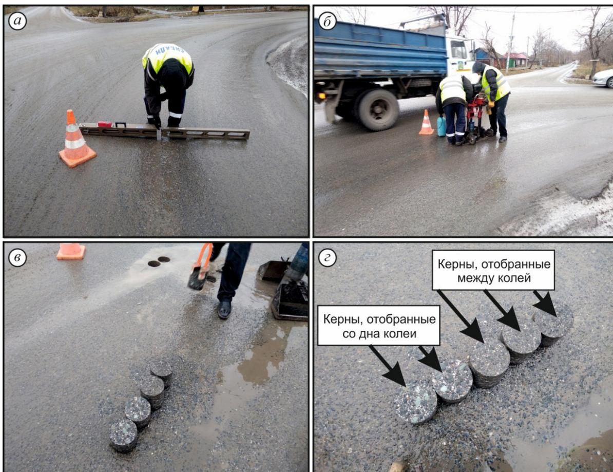
Рисунок 4 – Иллюстрация работ при детальном обследовании износа:
