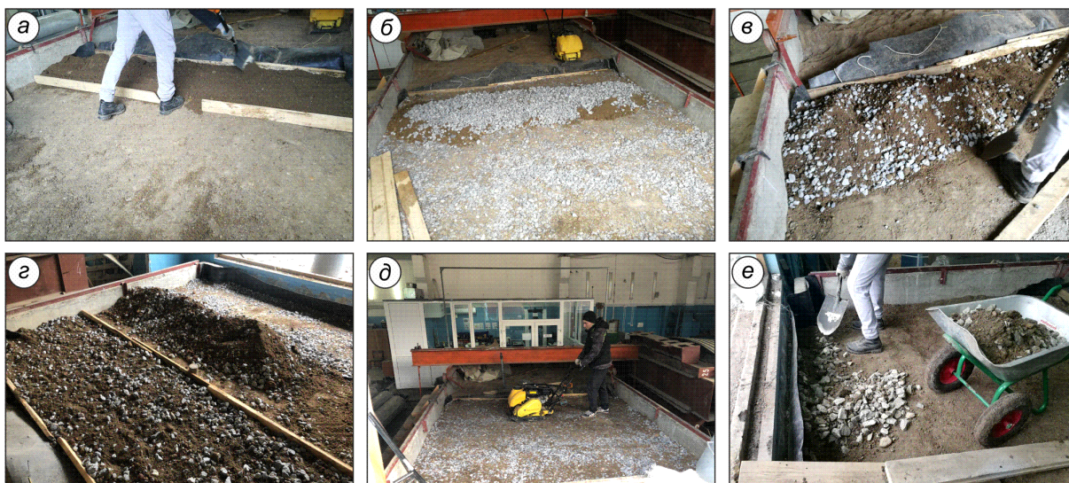
Рисунок 3 – Иллюстрации строительства модели грунтощебеночного слоя: а – подача требуемого количества грунта в секцию; б – подача в секцию щебня в требуемом количестве; в – смешивание щебня и грунта; г – визуальная оценка однородности; д – уплотнение слоя вибрационной плитой; е – демонтаж слоя после испытания
