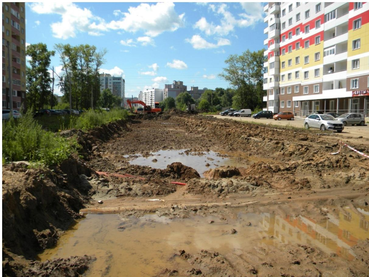
Рисунок 1 – Удаление верхнего слоя грунта с подстилающего слоя автодороги
