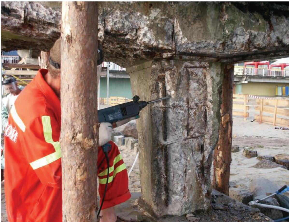
Рисунок 6 – Процесс подготовки опоры эстакады к производству ремонтных работ
