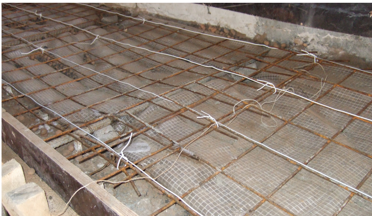
Рисунок 8 – Процесс установки греющих проводов при подготовке перекрытия здания академии дзюдо к бетонированию
