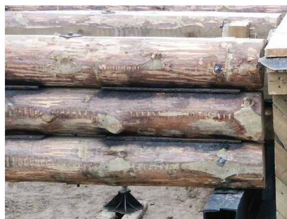
Рисунок 1 – Прогон, установленный на опору моста
