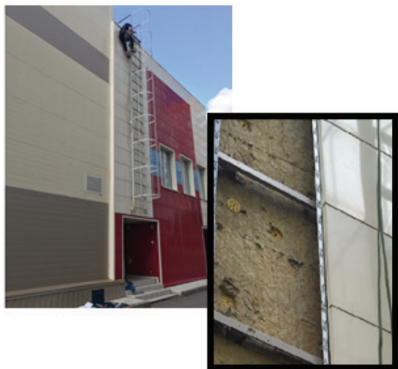
Рисунок 1 – Стена административно-бытовой части корпуса УНПЛ ААИСК с утепленным вентилируемым фасадом системы «АК-580С»
