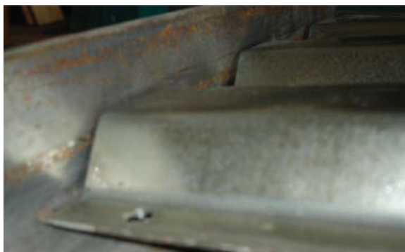
Рисунок 3 – Крепление профнастила к опорным элементам
