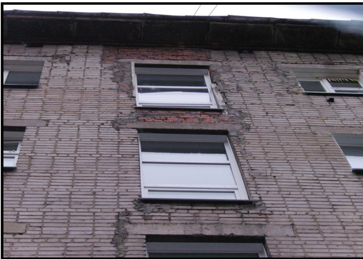
Рисунок 3 – Локальный участок перекладки наружной стены
