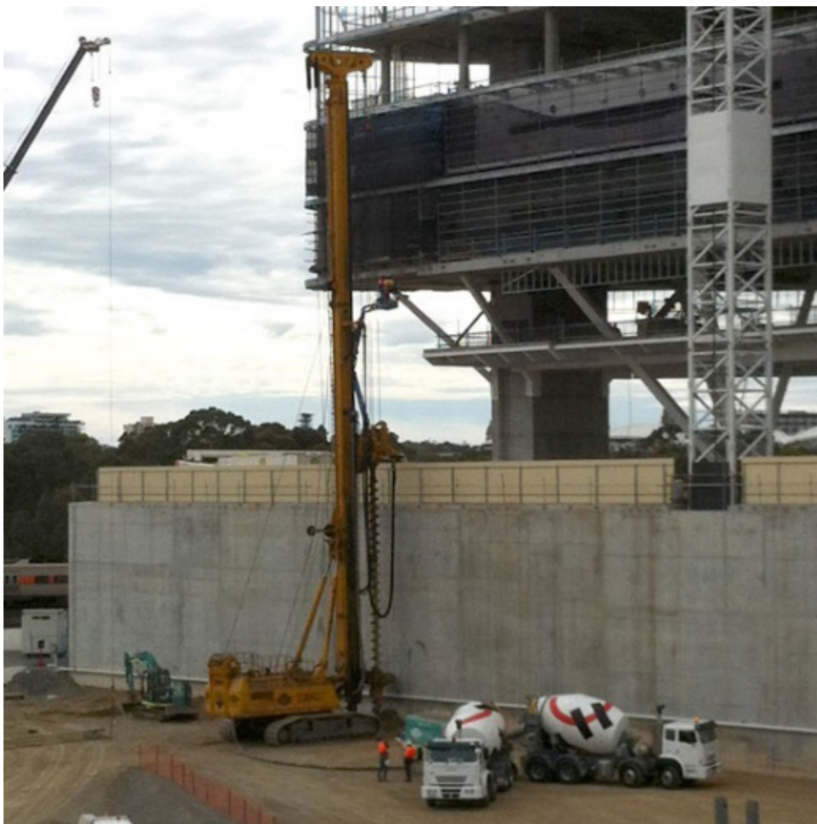
Рисунок 2 – Буровая установка MAIT HR 420-800 CFA для выполнения свай по технологии НПШ 5
