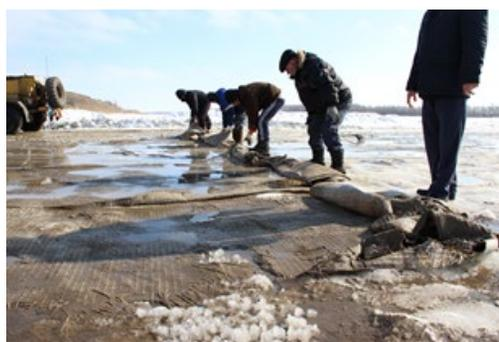
Рисунок 6 – Укладка геосинтетики зимой и извлечение её весной
