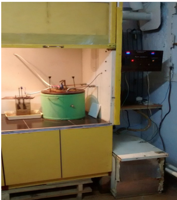
Рисунок 4 – Установка по поддержанию температуры электролита хромирования (справа внизу) с панелью управления (справа сверху)
