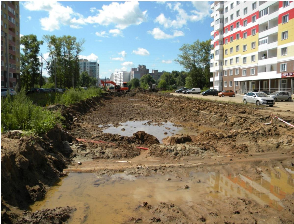
Рисунок 1 – Удаление верхнего слоя грунта с подстилающего слоя автодороги
