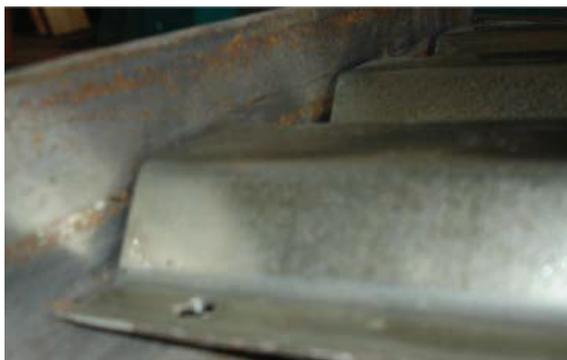
Рисунок 3 – Крепление профнастила к опорным элементам
