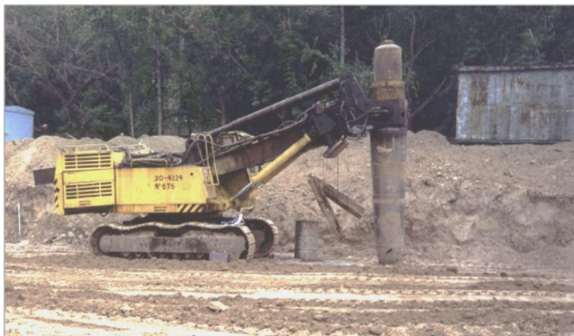
Рисунок 1 – Агрегат с рабочим оборудованием для глубинного трамбования грунта [19]
