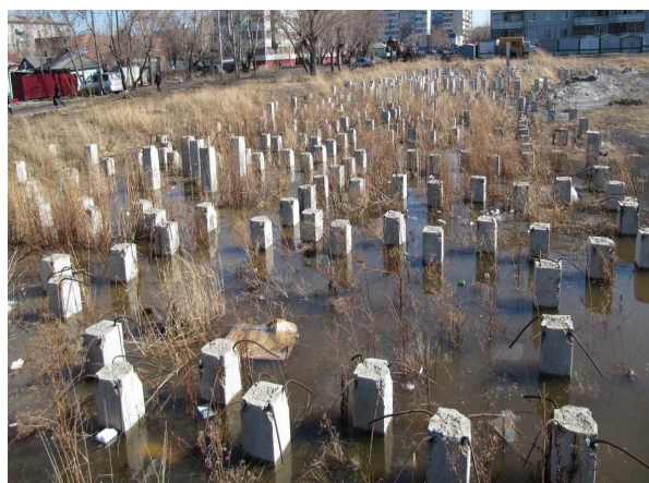
Рис. 3. Фактическое состояние свайного поля под многоэтажный жилой дом
