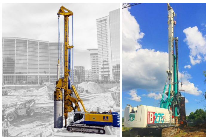
Рисунок 4 – Буровые установки для устройства свай под защитой обсадной трубы фирм Bauer (BG 28H) и Casagrande (B275 XP-2) 7
