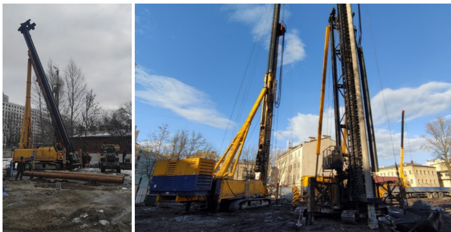
Рисунок 6 – Установка для устройства свай Fundex Источник: составлено авторами.
