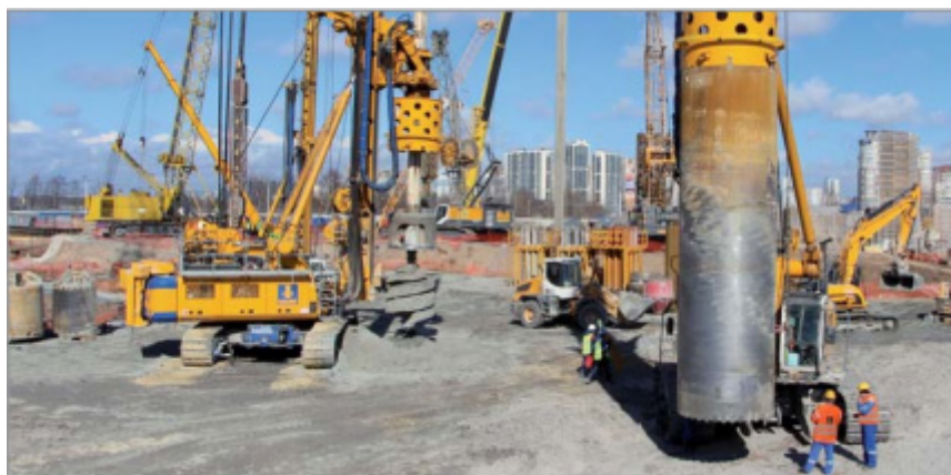
Рисунок 1 – Устройство свай Келли под защитой обсадной трубы для небоскреба Лахта-центр в Санкт-Петербурге 2
