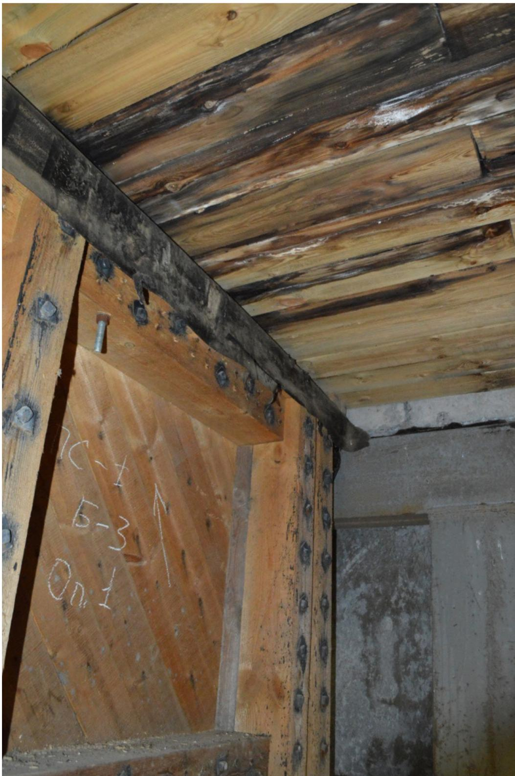
Рисунок 10 – Следы протечек воды и мест гниения поперечного настила у шкафной стенки
