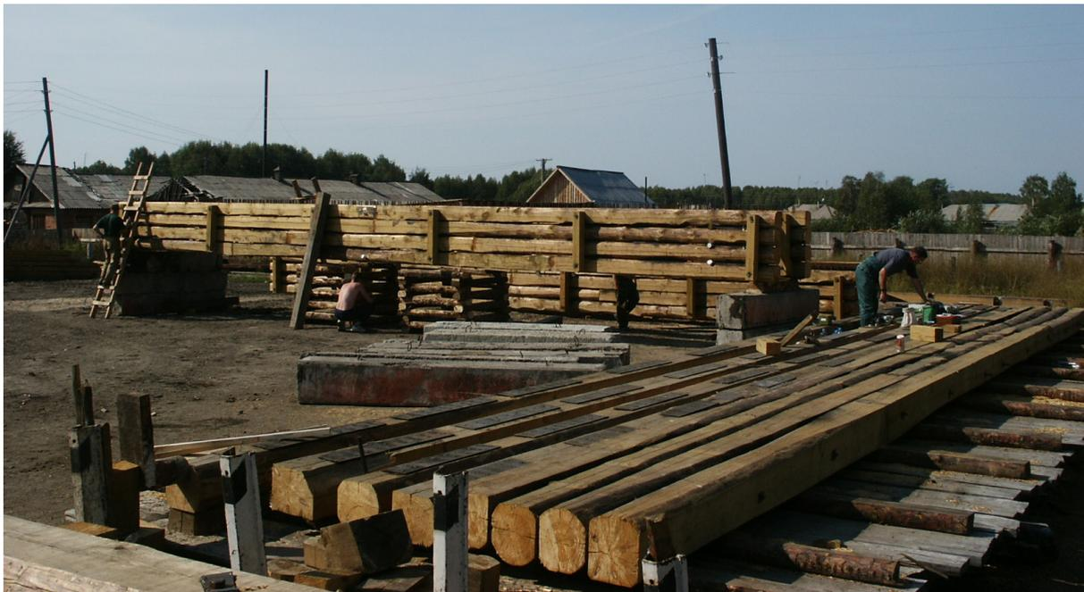
Рисунок 2 – Изготовление составных прогонов из бревен длиной 15 м
