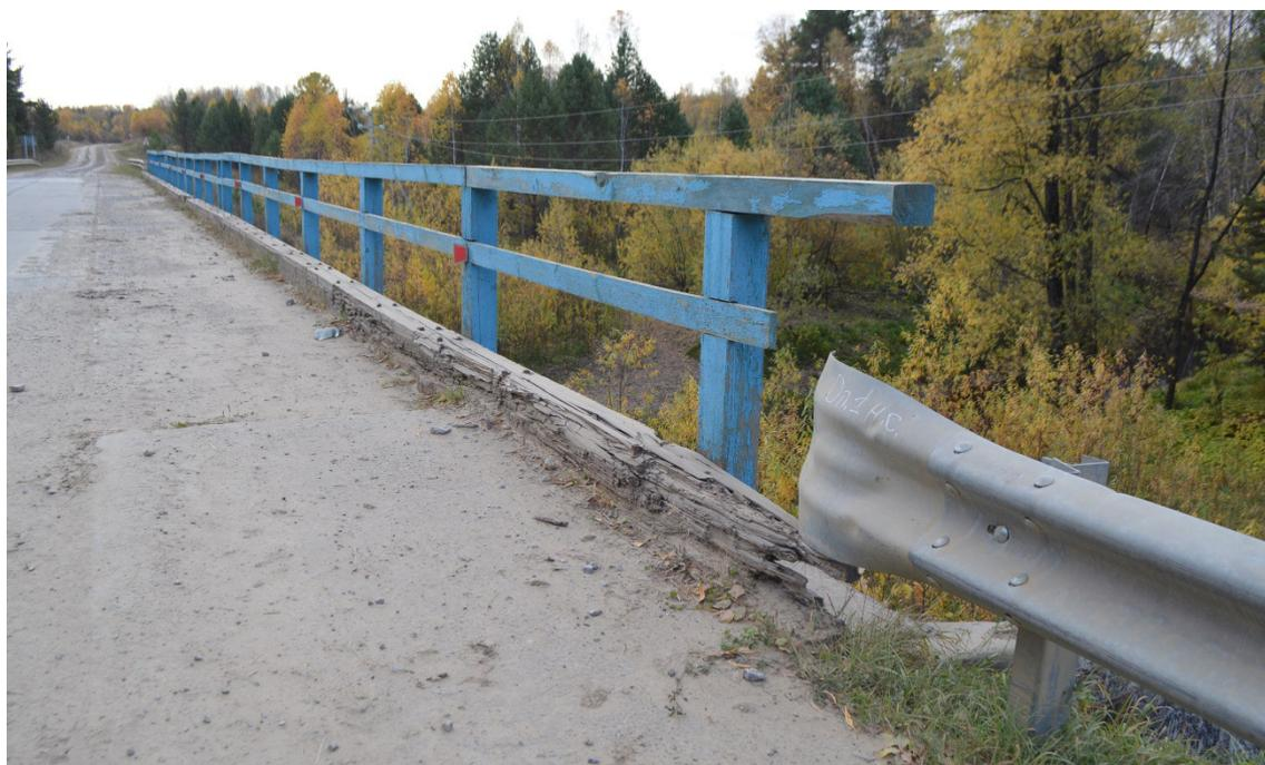
Рисунок 13 – Разрушение колесоотбойного бруса, пораженного гнилью
