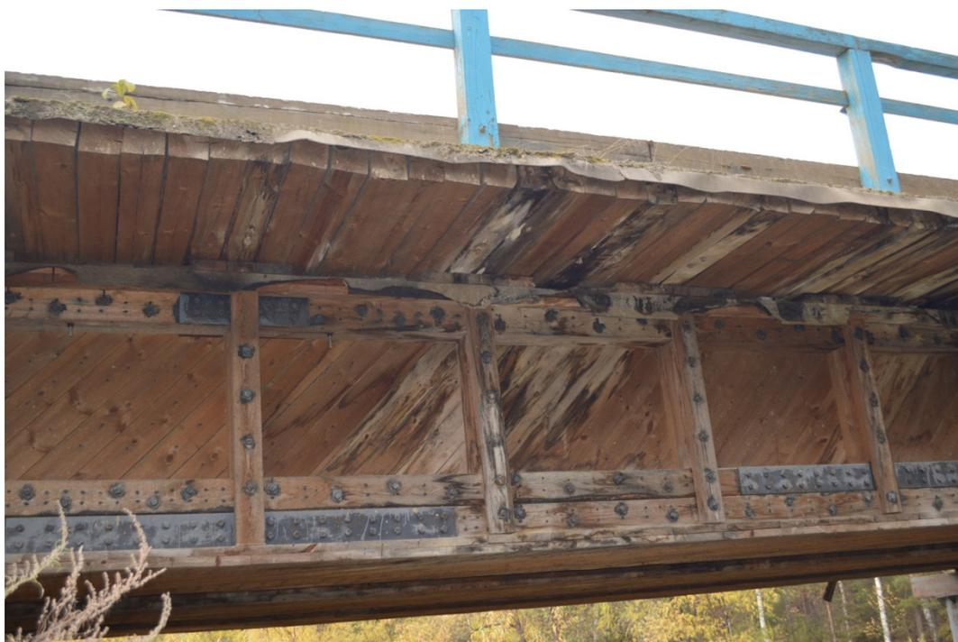
Рисунок 12 – Следы протечек воды и мест гниения стенки из перекрестных досок
