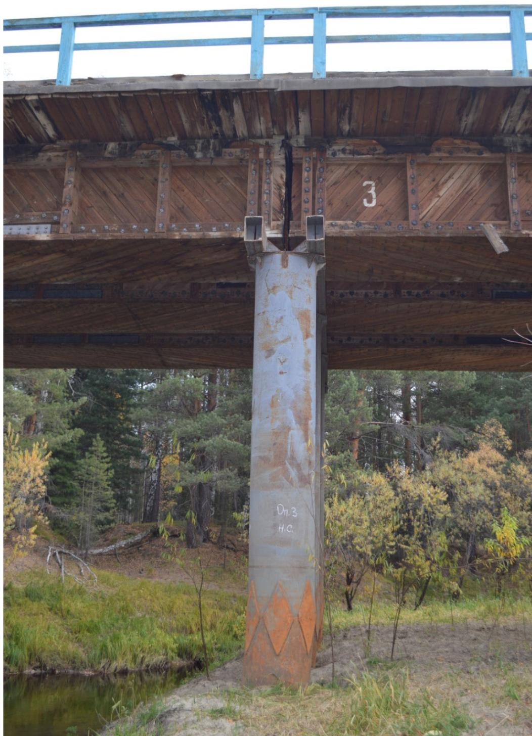
Рисунок 11 – Следы протечек воды и мест гниения поперечного настила над промежуточной опорой
