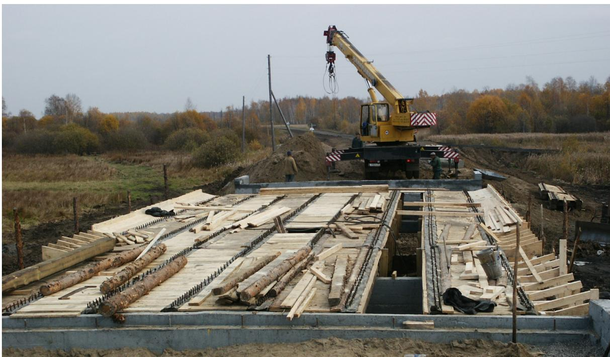
Рисунок 3 – Изготовление железобетонной плиты проезжей части
