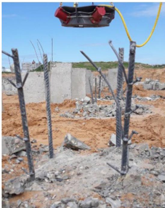
Рисунок 6 – Полное срезание оголовка железобетонной сваи до уровня основания
