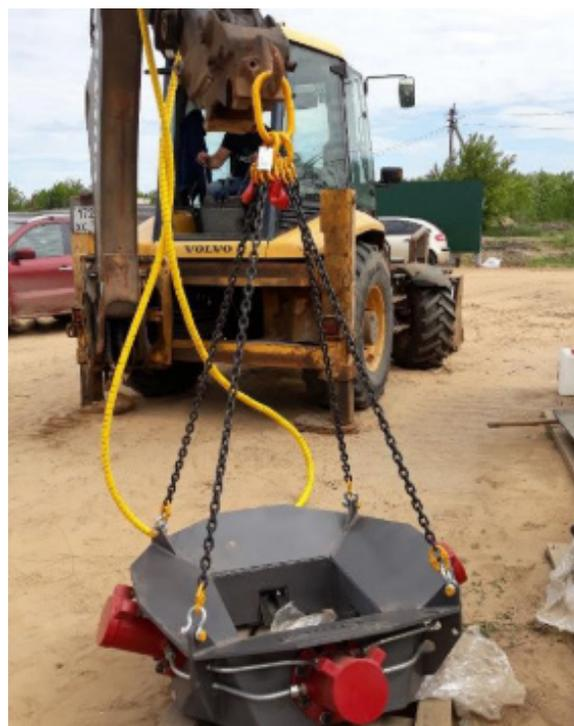
Рисунок 1 – Оборудование для срезки оголовков железобетонной сваи, установленное на экскаваторе Volvo BL-71.
