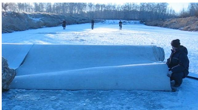
Рисунок 4 – Погружение геокомпозита в «лайну» и протаскивание его подо льдом
