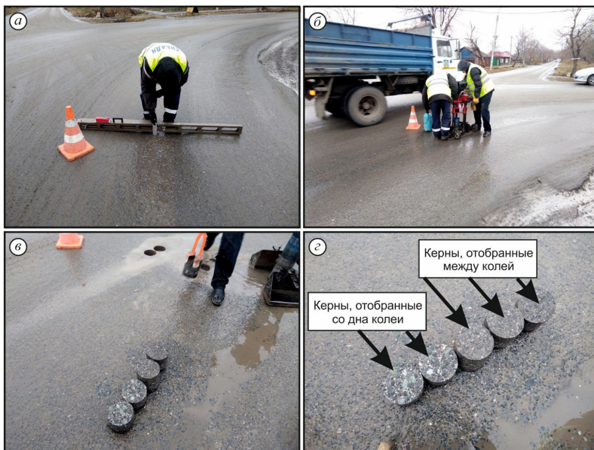
Рисунок 4 – Иллюстрация работ при детальном обследовании износа:
