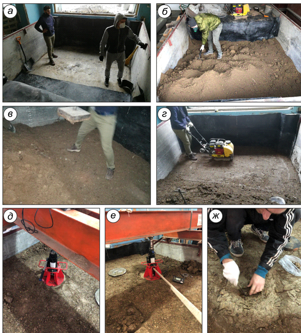
Рисунок 2 – Иллюстрации строительства и испытания модели земляного полотна: а – подготовленный лоток; б – разравнивание грунта; в – трамбовка слоя; г – уплотнение слоя вибрационной плитой; д – установка штампа; е – испытание; ж – отбор грунта после испытания для определения влажности
