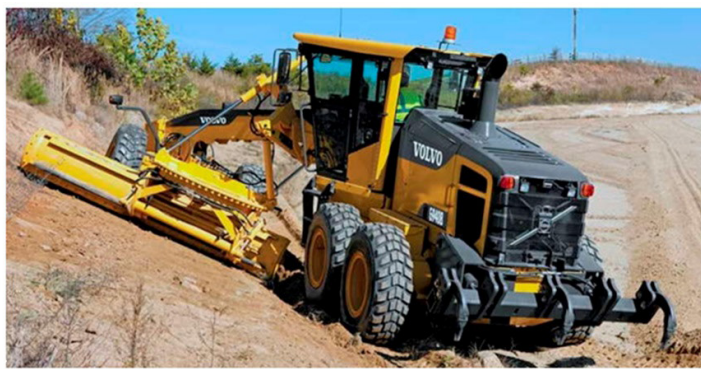
Рисунок 1 – Укладка и расширение дорожных обочин
