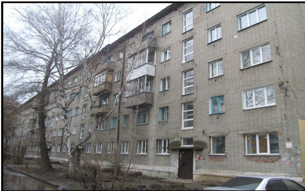
Рисунок 2 – Общий вид. Здание со стороны подъездов
