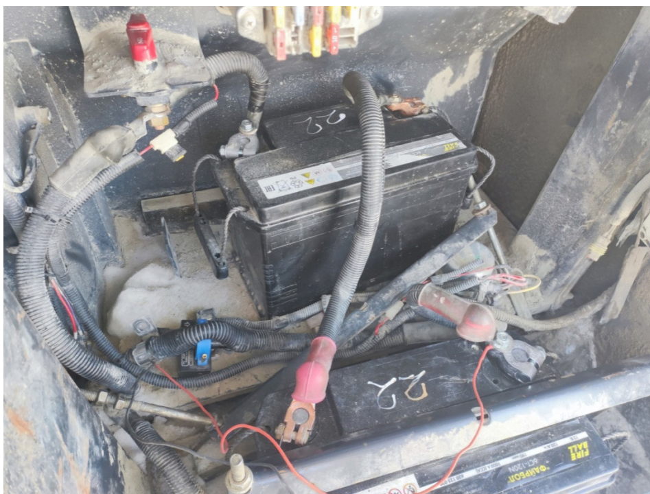
Рисунок 5 – Место монтажа устройства марки Ablogger V2.1 Источник: составлено авторами.
